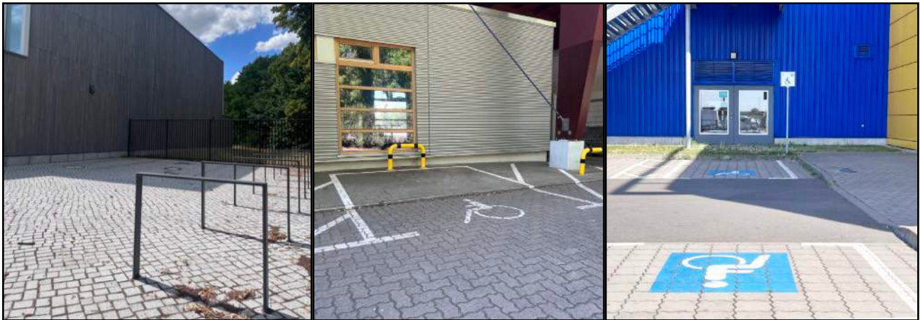
Abb. 04 l.u.: neu gebautes Wegeleitsystem im Eingangsbereich führt nicht in den bestehenden Weg (negativ)
