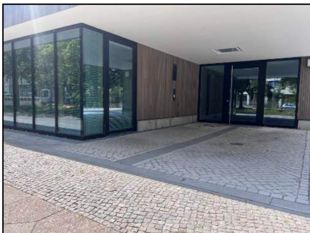
Abb. 06: reibungsarmes Pflaster im Denkmalschutzbereich (Unterschied: geschnittenes - rollbares - und geschlagenes Pflaster)
